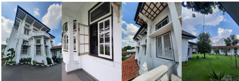
Gambar 3. Ventilasi alami di setiap ruangan Gedung Pusat Penelitian Kelapa Sawit Medan
