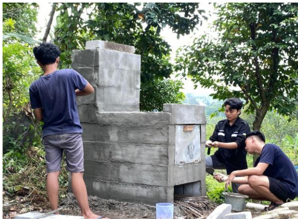
Gambar 2 Pembuatan insinerator sederhana.
