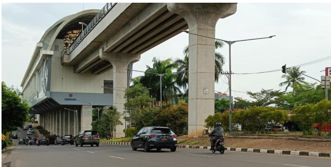
Gambar 1. Kondisi eksisting lokasi penelitian
