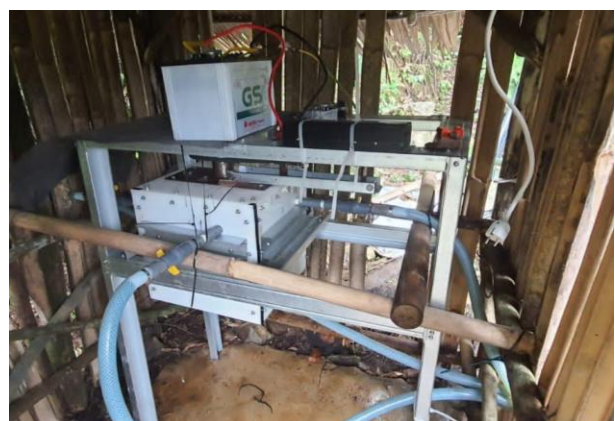
Gambar 9 Pembangkit listrik tenaga mikro hidro.
