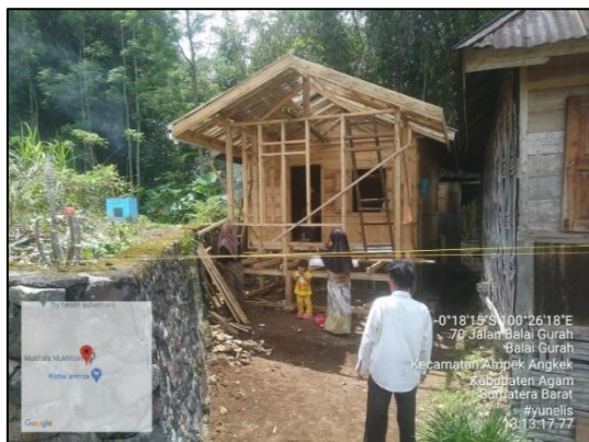
(b) Rumah Kondisi Renovasi (50%)
