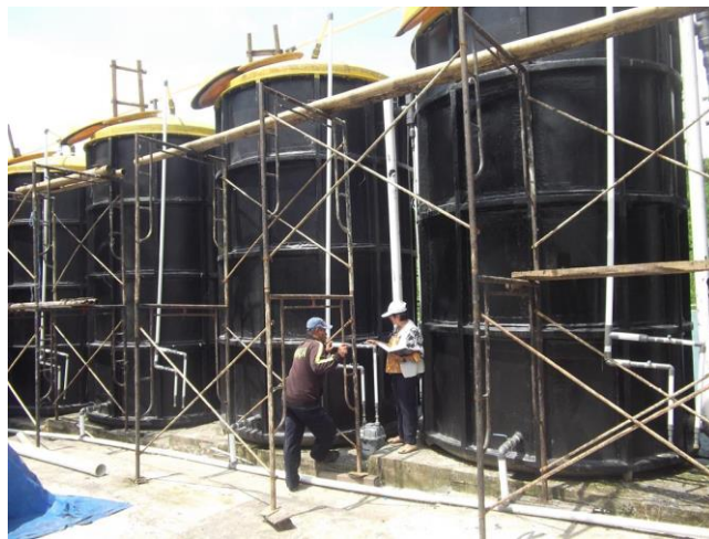
Gambar 2. Proyek pengerjaan Biotoilet (Sumber: Dokumentasi PRLTB, 2015)
