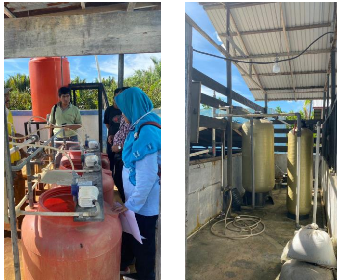
Gambar 6. Proses Desinfeksi pada WSS Saliki
