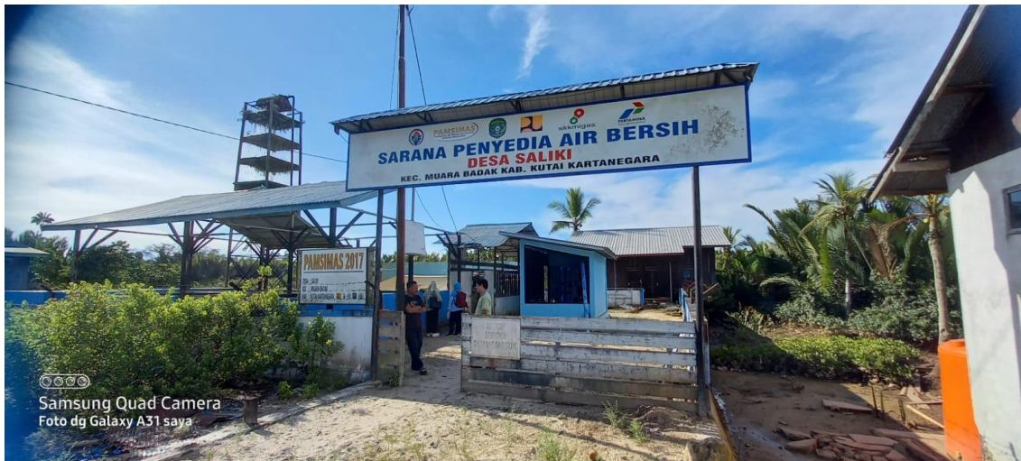
Gambar 1. Instalasi WSS Saliki
