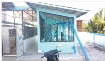
Gambar 5. Rumah Pompa WSS Saliki
