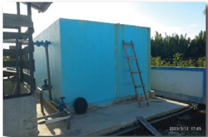
Gambar 8. Bak Filtrasi pada WSS Saliki
