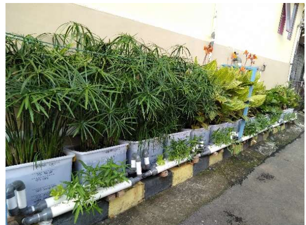
Gambar 3 Kontruksi Bak Bioretensi.
