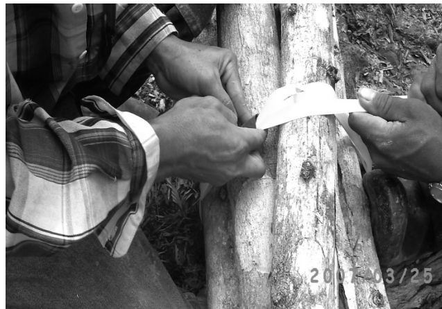
Gambar 1 Metode pengikatan kayu dengan tali.
