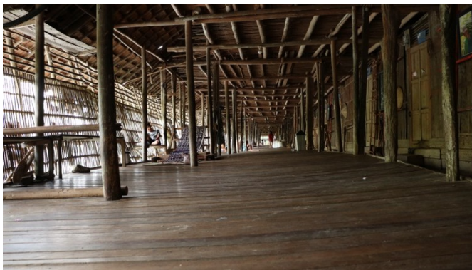
Gambar 10. Kondisi teras dalam Rumah Bentang Ensaid Panjang
