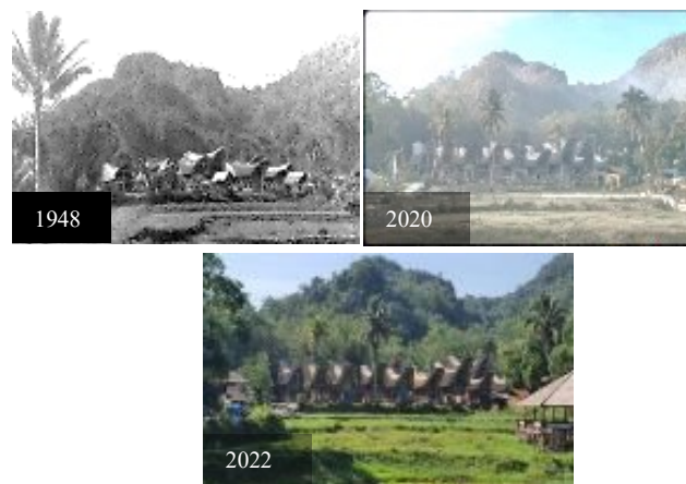
Gambar 1. Desa Adat Kete' Kesu dari Masa ke Masa. Sumber: Facebook Toraja Tempo Dulu dan dokumentasi pribadi (2022)
