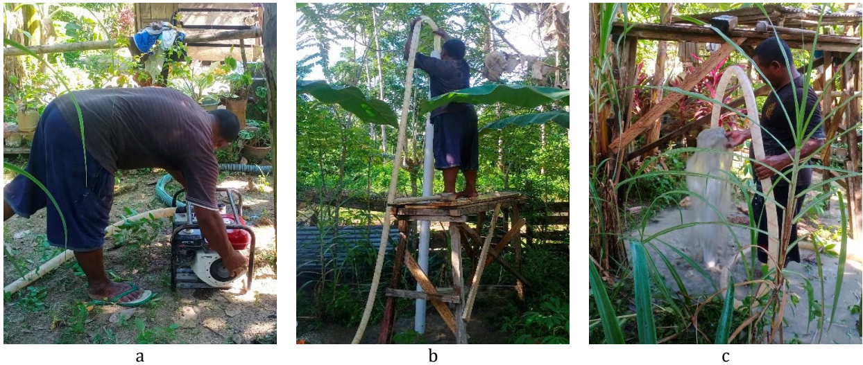
Gambar 4 a,b, dan c) Dokumentasi pengeboran air tanah di lokasi baru.
