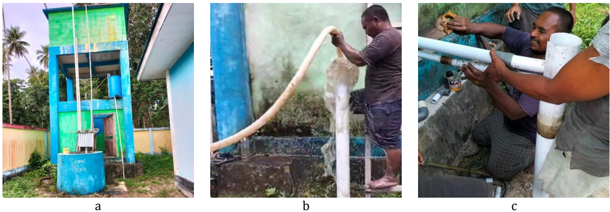
Gambar 2 Perbaikan Pamsimas Desa Wai U yang dibangun tahun 2018: a) Menara air Pamsimas 2018, b) Pembuatan sumur baru di lokasi Pamsimas 2018, dan c) Pemasangan pipa baru.
