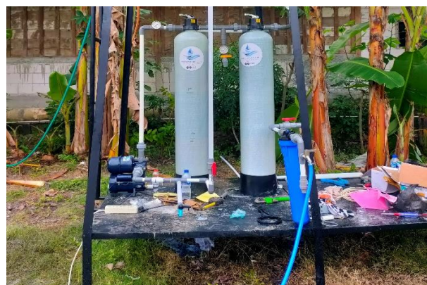
Gambar 6 Instalasi teknologi multimedia filter di lapangan.
