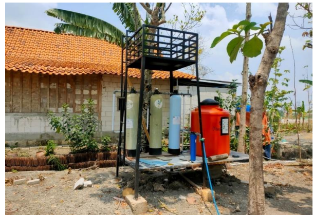
Gambar 6 Instalasi teknologi multimedia filter di lapangan.
