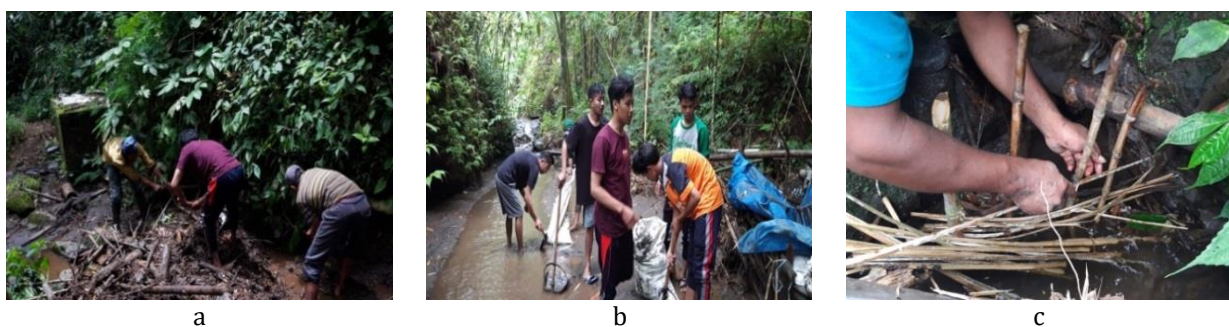
Gambar 6 a dan b) Pembersihan sumber mata air yang terkena material lumpur dan tertutupi ranting pohon dan c) Pembuatan tanggul dan upaya perbaikan pipa.
