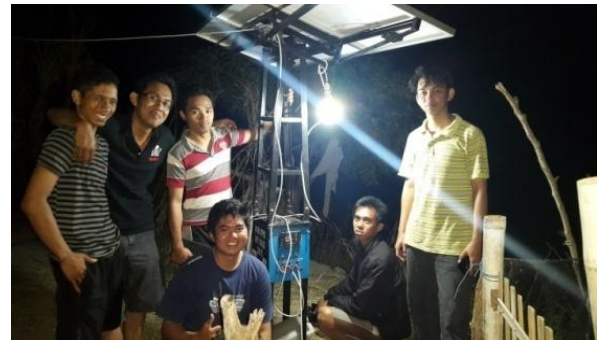
Gambar 7 Penerapan teknologi sel photovoltaik untuk penerangan.
