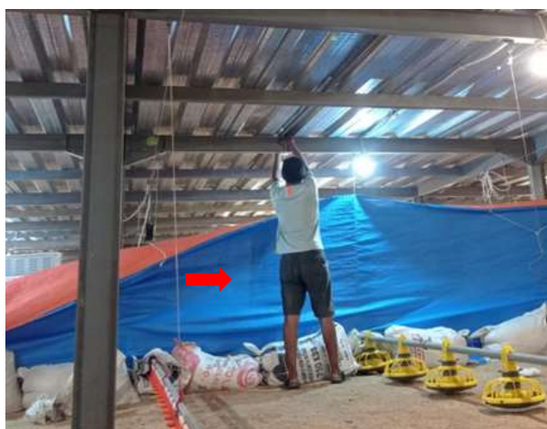
Gambar 7 Pemasangan layar blocking (panah merah).
