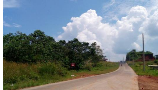
Gambar 20. Kondisi tiang listrik
