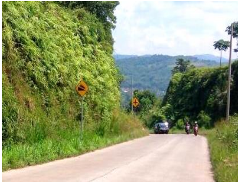
Gambar 18. Kondisi rambu dan marka Jalan Lingkar Leuwiliang
