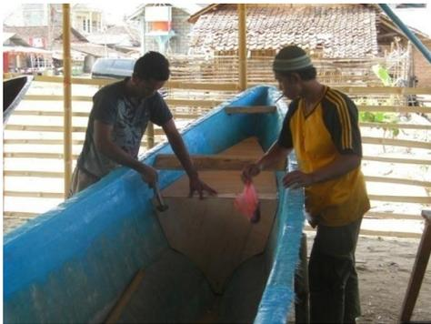
Gambar 7 Pembuatan *ballast*
